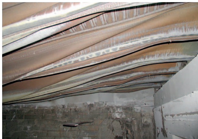
Obr. 2 – Deformace plechu u podpory
