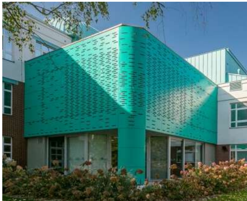
Plechý i kompozitní panely lze perforovat či embosovat
