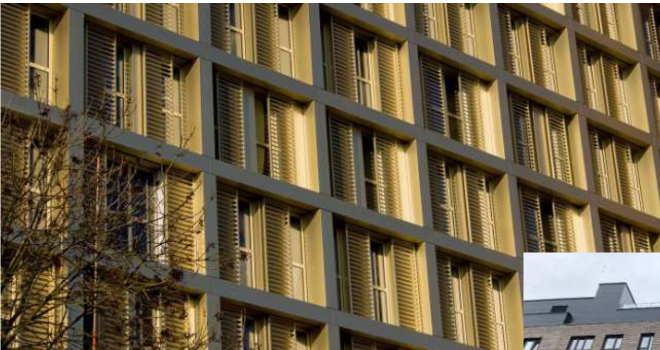
Real Anodized Alubond Bürogebäude
