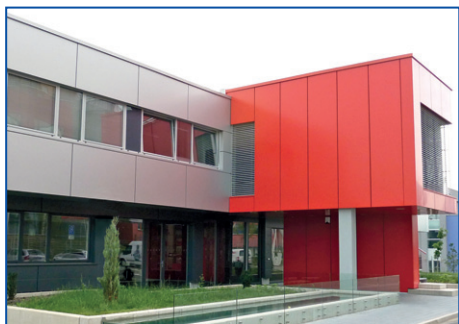
Fronius Praha – kombinace fasád ze sendvičových panelů, fasádních lamel a hliníkových kompozitů ACP (bondů)
