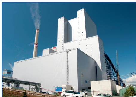
Elektrárna Ledvice – různé typy obvodových plášťů, skládané fasádní pláště Rockprofil a KI-KP, nejvyšší opláštěná stavba v ČR - 142 m, garance fasád 25 let s povrchem Colorcoat Prisma
