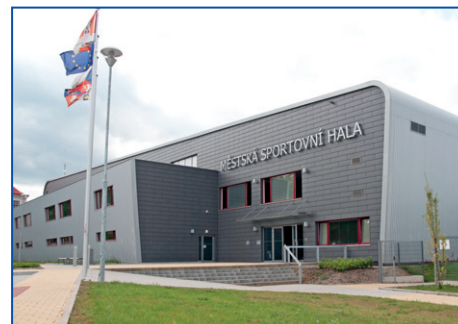
Sportovní hala Skuteč – zakružované fasády z TR plechů, skládaná fasáda Rockprofil s pohledovým materiálem Cetris
