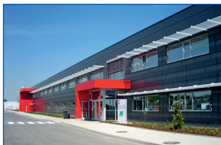
Lego Kladno – nosné střešní TR plechy a vstupy z hliníkových kompozitů ACP (bondů)
