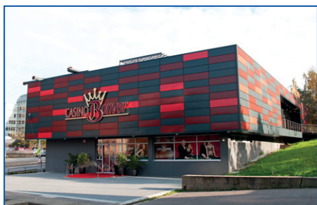
Casino Bonver Praha – odvětrávaná fasáda KP Form+
