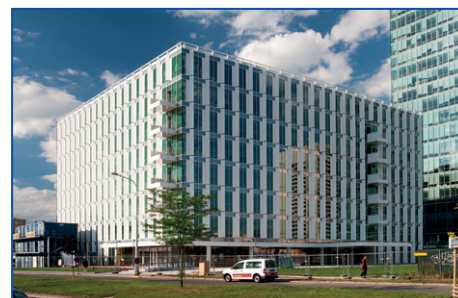
City Green Court Praha – hliníkové kompozitní panely (bondy) Alpolic/fr s povrchem Lumiflon lesk 80 %
