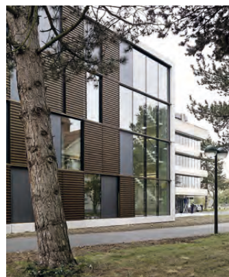
Příklad celoplošně perforovaného trapézového profilu
