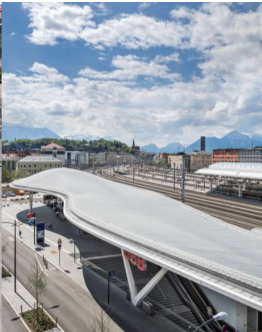
Der Hauptbahnhof Salzburg
