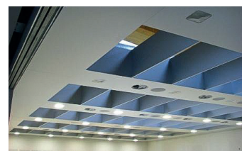
Obklady z desek PHONOFLEX pomáhají snížit tloušťku obkladů a šetří tak prostor v objektu.
