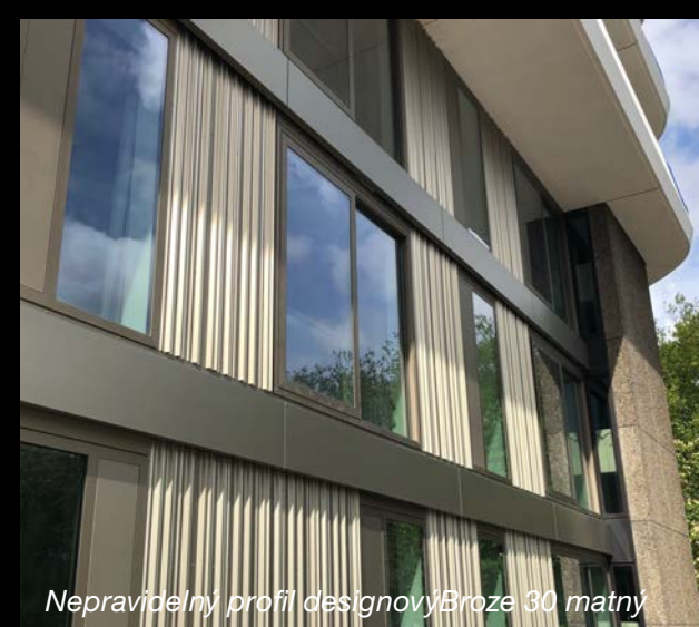
Kompozitní panel Alubond A2 s pláštěm z eloxovaného hliníku Gold 30 SMF
