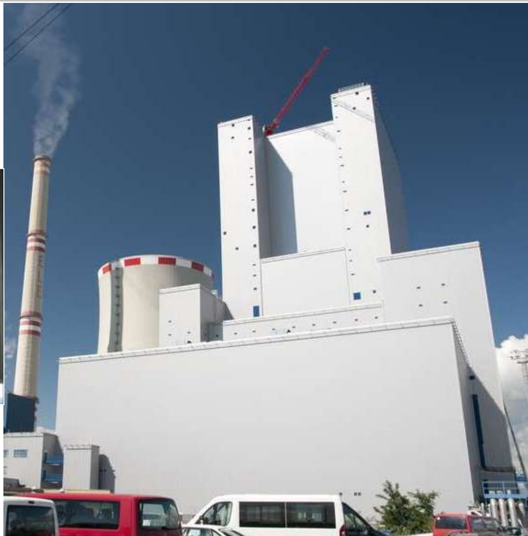
Elektrárna Ledvice nový zdroj Kazetová stěna Rockprofil do výšky 123m
