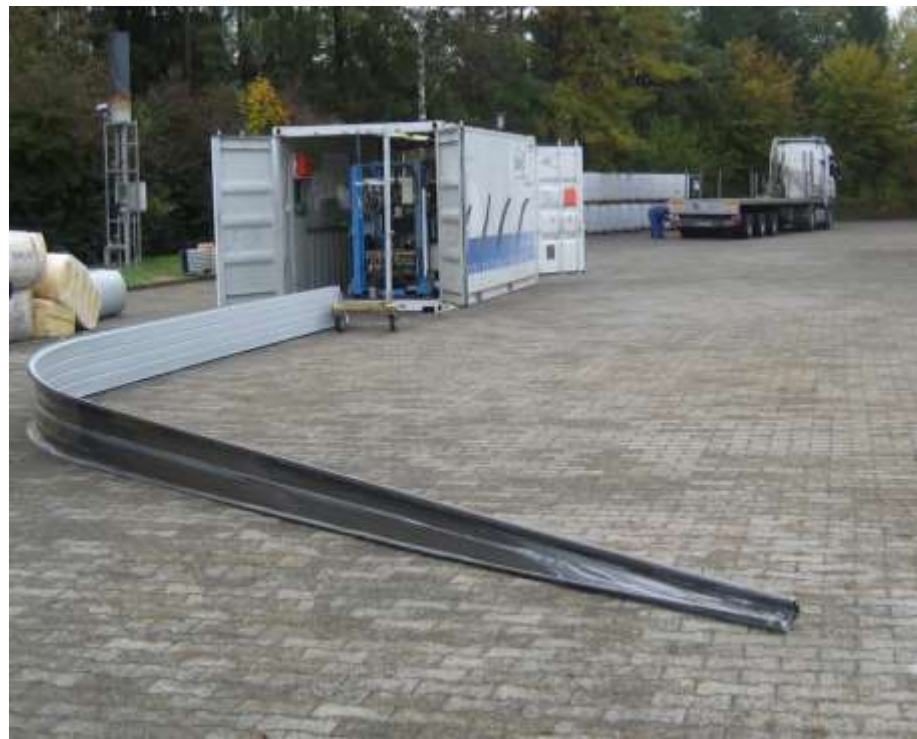
Zakružení na stavbě
